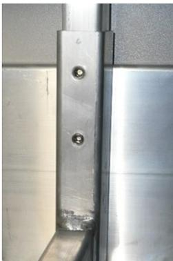
Die Türpfosten durch die „Türschiene – Boden“ in die Fußelemente stecken und mittels werkseitig vorbereiteter Madenschraube M8 x 12mm festschrauben. Die Türpfosten sind spezielle Pfosten, da sie nur Einseitig über Holmlöcher verfügen.
